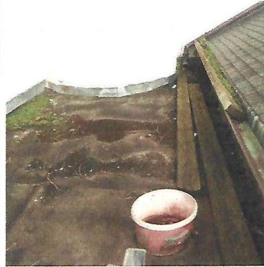
plat dak tussen traptoren en sacristie
