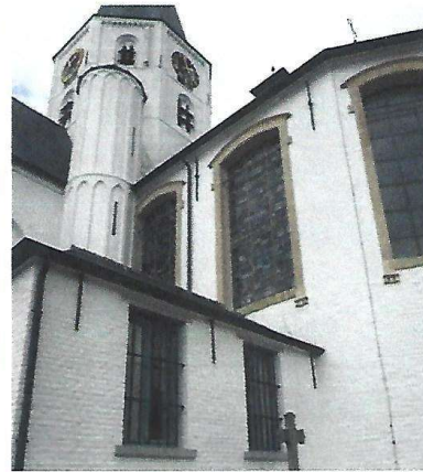
muurankers en diefijzers
