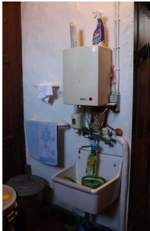
Fig. 69: Sint-Martinuskerk Rijmenam uitgietskaf met warmwaterboiler. IGEMO, 2025.
