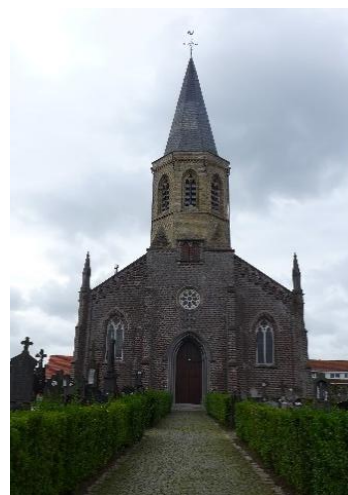
Figuur 51 Noordgevel van de kerk
