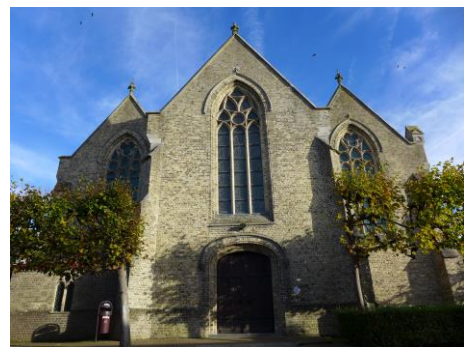
Figuur 38 Westgevel van de Sint-Hadrianuskerk
