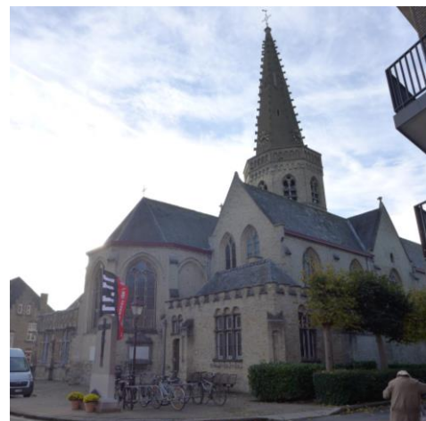
Figuur 41 Zicht op het hoofdkoor van de Sint-Hadrianuskerk, geflankeerd door de sacristie en bergruimte
