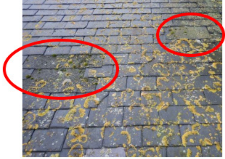
Dakvlak 11, voorlopige leihertellingen met stroken asfalt
