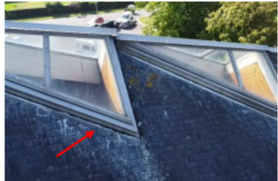
Scheurtjes in de bovenop aangebrachte vloeibare bescherm laag
