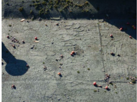
Scheurtjes in de bovenop aangebrachte vloeibare bescherm laag
