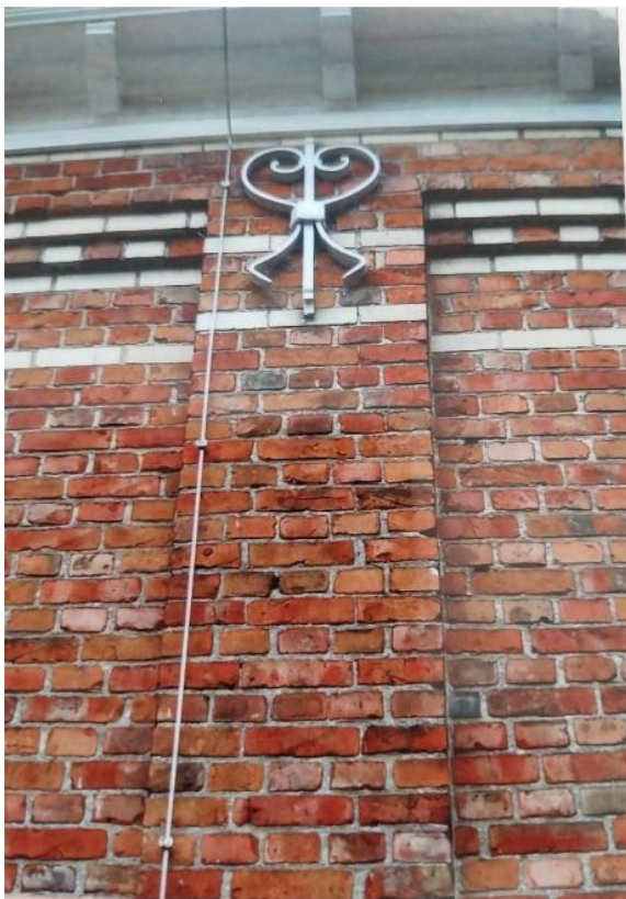
Figuur 2.3.12: vernieuwing bliksembeveiliging in 2017.
