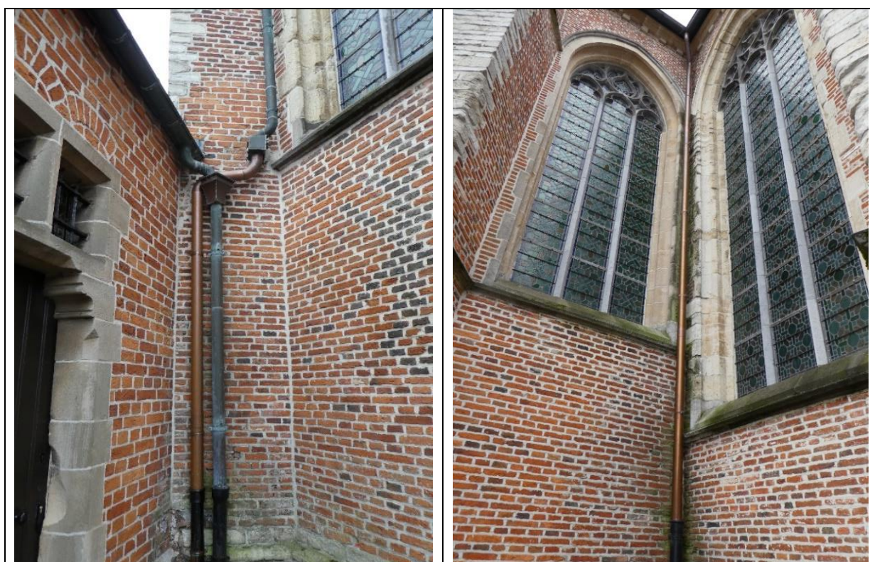
Figuur 2.1.26 a en b: de meest dringende herstellingen aan de dakgoten bij de achteringang van de sacristie (a) en het hoogkoor (b) werden uitgevoerd.
