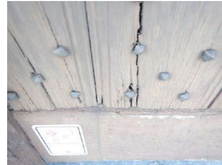
loskomende nagelingen en windbarsten
