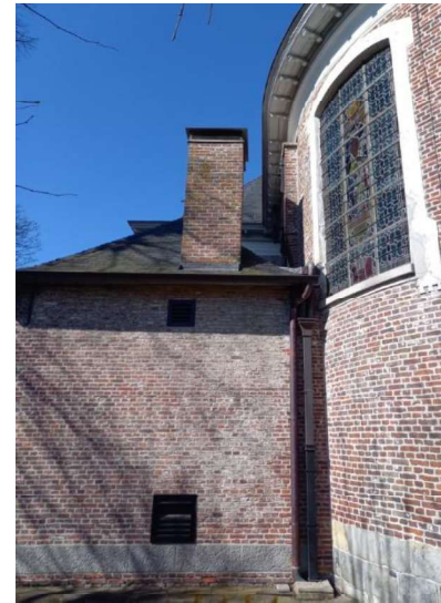
dak sacristie en afvoerpijpen zijn hersteld
