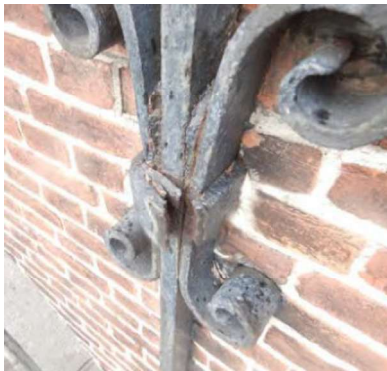
opengebarsten strop
