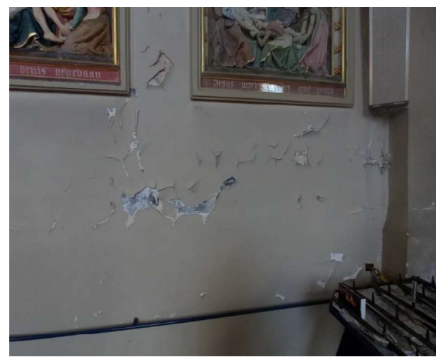
afbladderende verf
