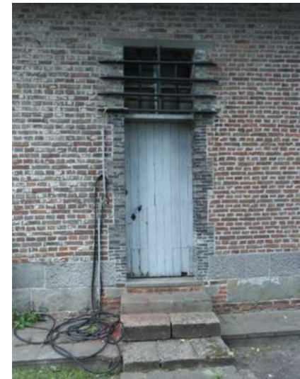
toegang tot de stookruimte'
