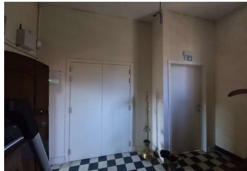
vernieuwde brandwerende wand
