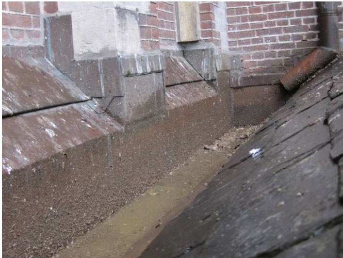
binnengoten raken makkelijk verstopt
