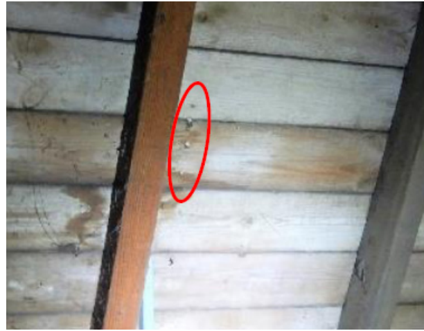
Voorbeeld van enkel op de leibebording vastgezette ladderhaak: zie drie schroeven
