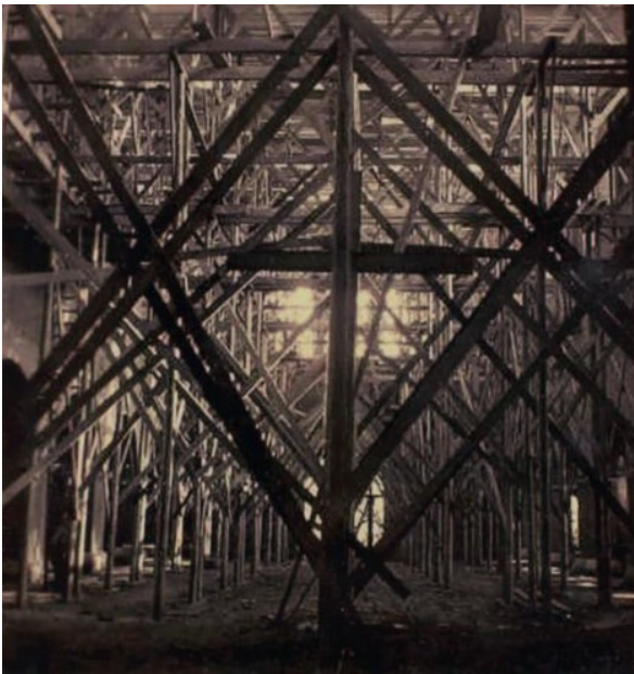
Tijdelijke stutten in de kerk
