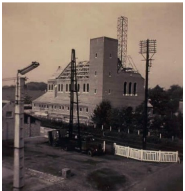
Bouwwerken in een finale fase
