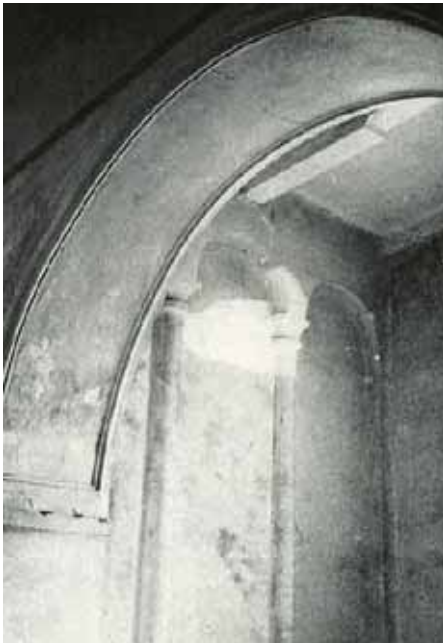
Figuur 52 Oostelijke binnenmuren van het transept van de Romaanse kerk 1940 (© Broeder Firmin)
