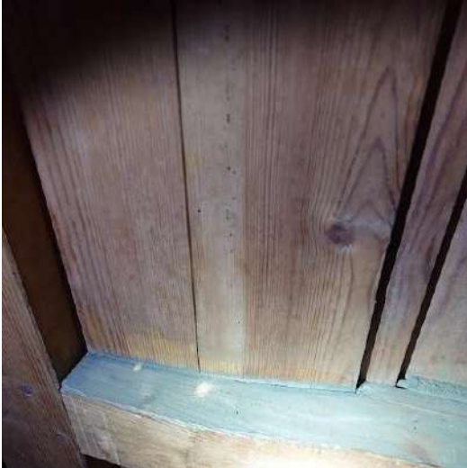
Oppervlakteschimmel aan de binnenzijde van de kast
