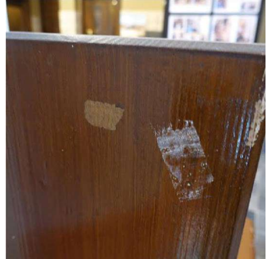
Schade door plakband
