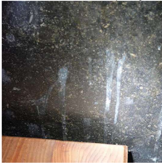
Vuil en opstuwings wand tussen schip en koor
