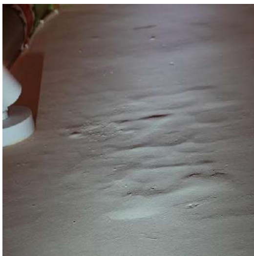
Blazen in de wanden (bij zuidelijk zijaltaar)
