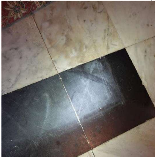
Verzakking van de vloer in de doopkapel
