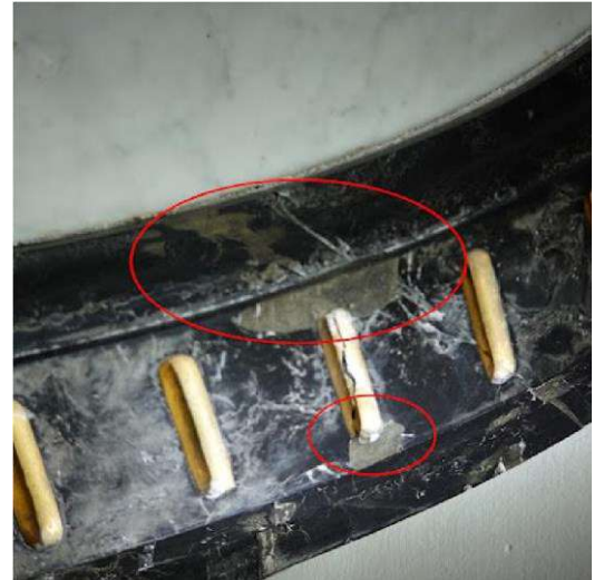
Invulling werd niet volledig op kleur gebracht
