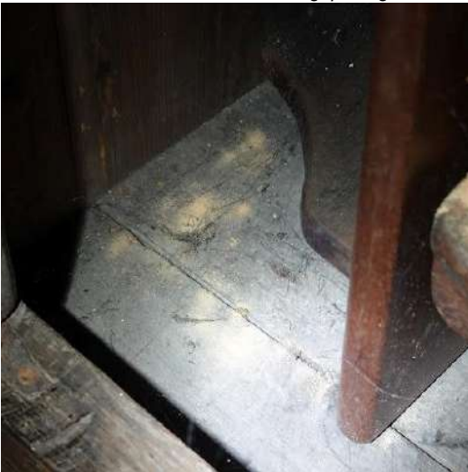
Uitvliegopeningen van de grote houtworm
