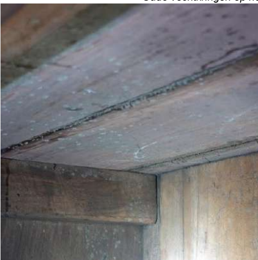
Oppervlakteschimmel aan de binnenzijde
