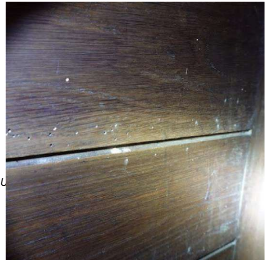
Uitvliegopeningen en hoopjes boormeel
