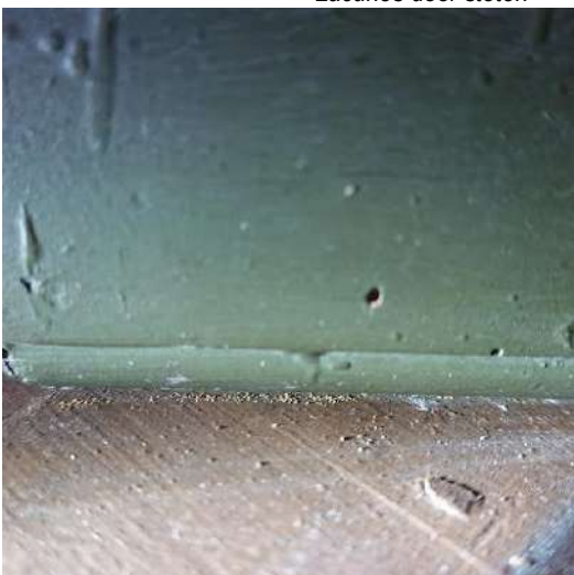
Zweem van boormeel op de houten sokkel
