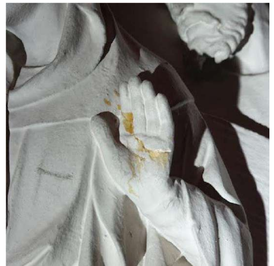
Verlijming is vergeeld (statie VIII)
