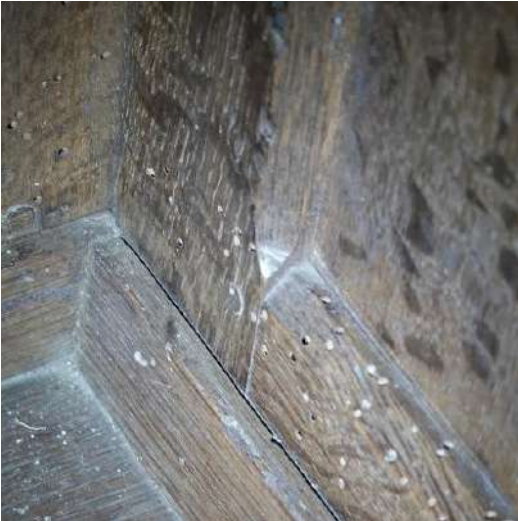
Uitvliegopeningen van de grote houtworm
