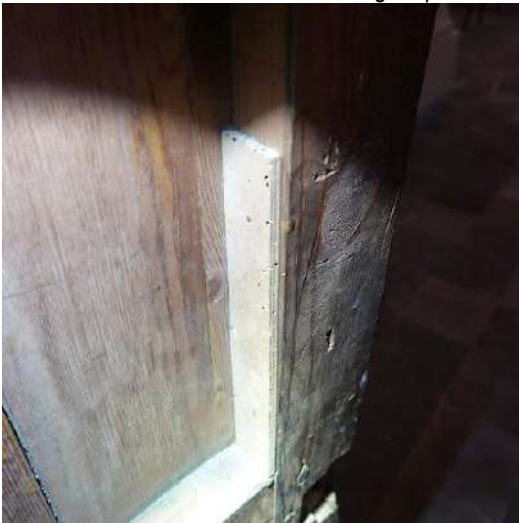
Aantasting in een nieuw stuk hout
