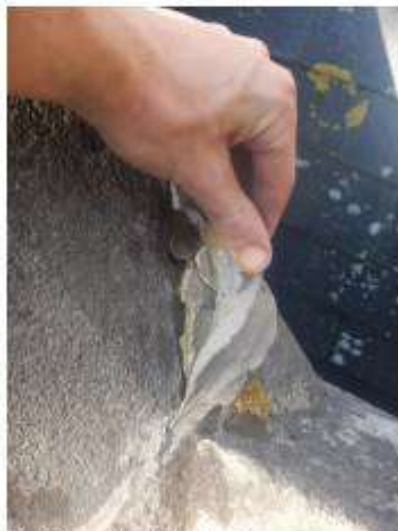
dak [2]-noordwestelijke hoek
