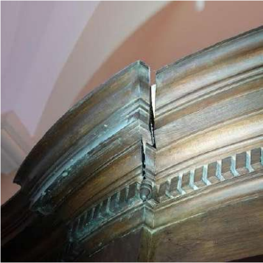
Aansluiting met de kroonlijst staat open
