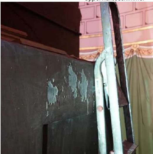
Stootschade aan de achterzijde van het altaar
