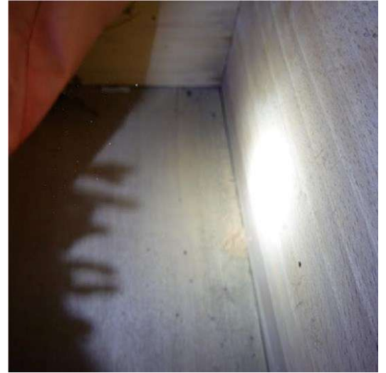
Boormeel en uitvliegopeningen aan de binnenzijde van
