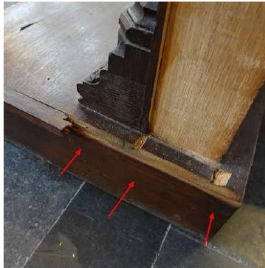
Lijst is afgebroken
