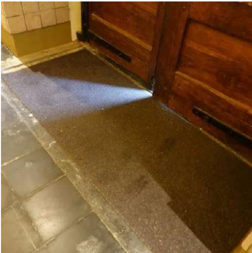
Inloopmat is op de ingewerkte mat gelegd
