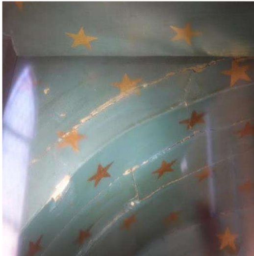
Verlaag is beschadigd t.h.v. de naden
