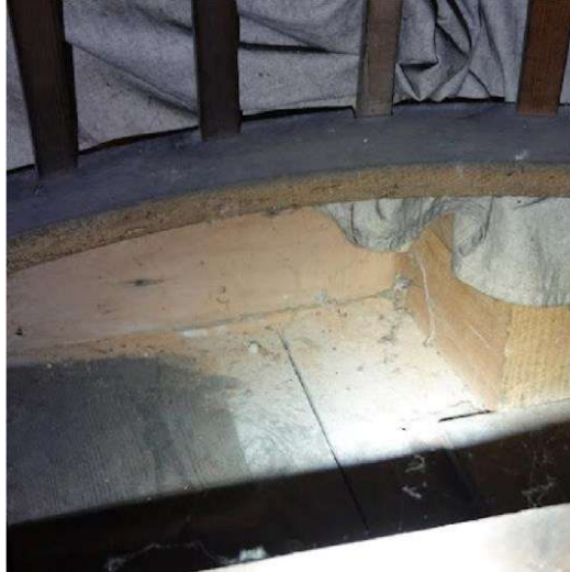
Oppervlakteschimmel aan de binnenzijde van de kast
