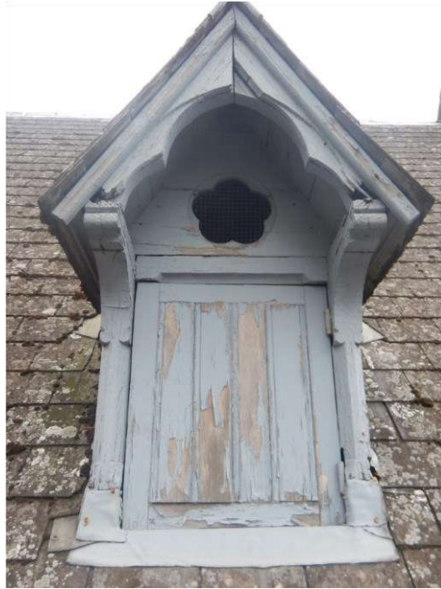
dak 6-zuid: dakkapel
