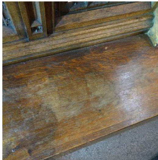
Vochtvlekken (oude schade)
