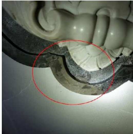
Invulling werd niet volledig op kleur gebracht
