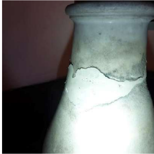
Invulling met incompatibel materiaal
