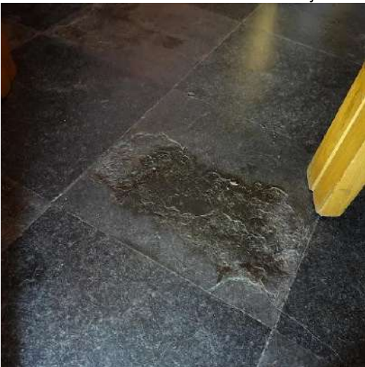
T.h.v. vochtige vlek treedt delaminatie op
