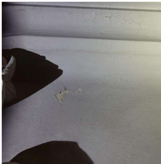
Opstuwing overschildering met lacune tot gevolg
