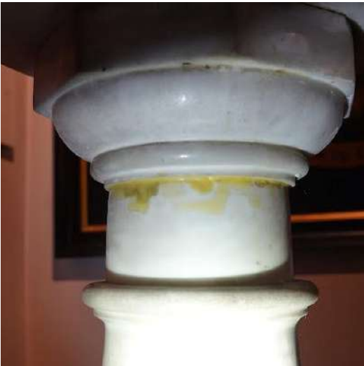
Invulling met incompatibel materiaal
