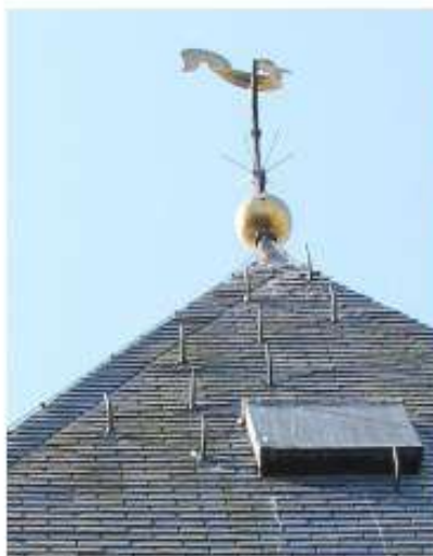
toren [1]: niet-genormeerde ladderhaken
