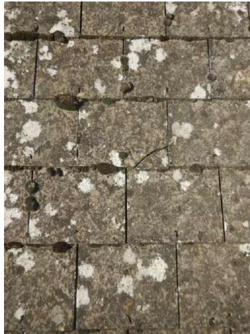
asbesthoudende leien verweerd, plaatselijk beschadigd
