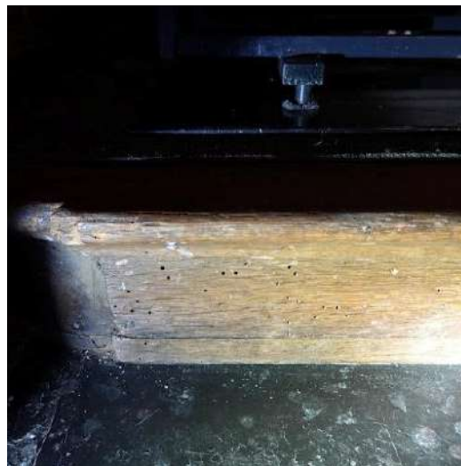
Uitvliegopeningen van de grote houtworm
