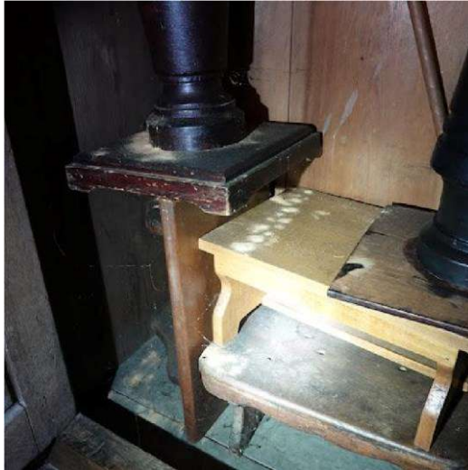
Uitvliegopeningen van de grote houtworm
