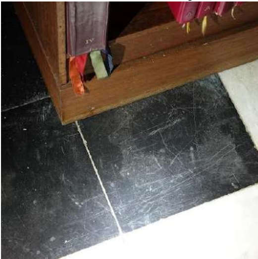
Verzakking van de vloer in de doopkapel
