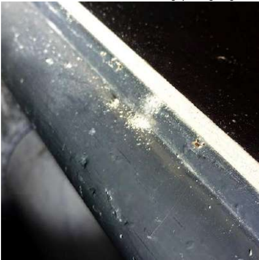
Uitvliegopeningen grote houtworm met boormeel
