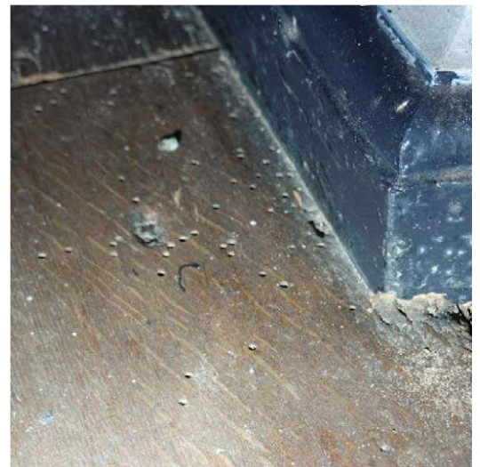
Uitvliegopeningen van de grote houtworm
