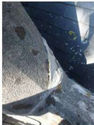
dak [2]-noordwestelijke hoek
