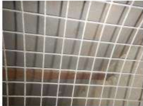
toren [1]: galmgaten: roestige stangen onder galmboarden
