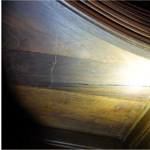
Aansluiting met de kroonlijst staat open
