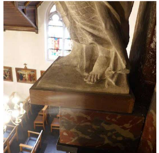
Voetstuk is te groot voor de sokkel
